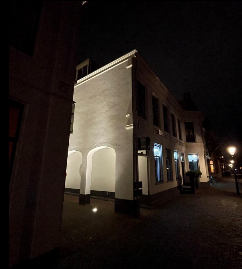
De zijkant is helderder dan de monumentale voorgevel
