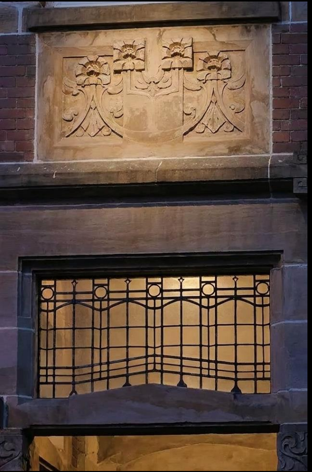
Gevel details, gevelstenen
